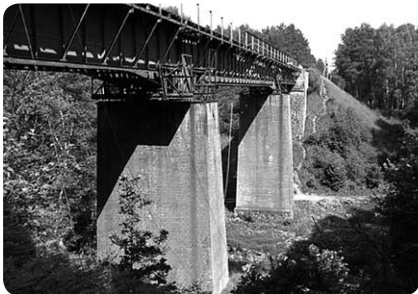
Most kolejowy nad Płociczną 1 km za Krępą
