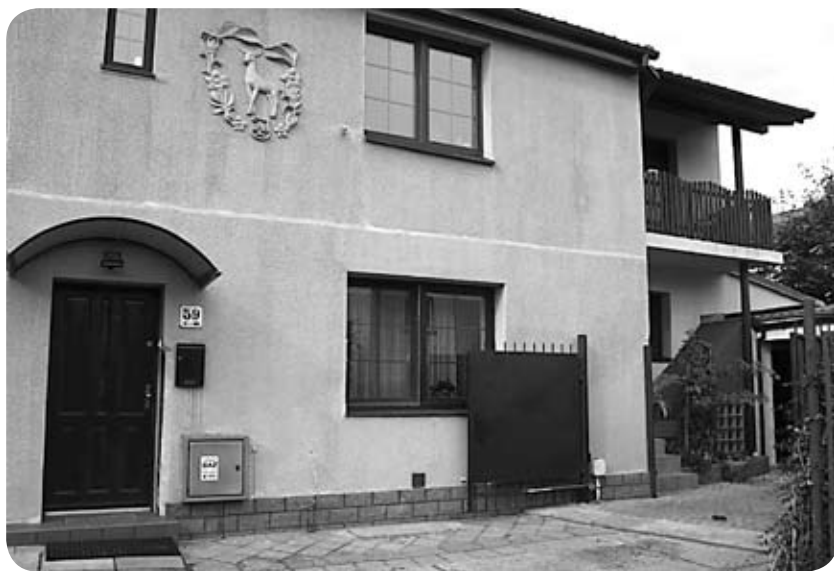
Nasz dom na Dubois 59, już po remoncie.
